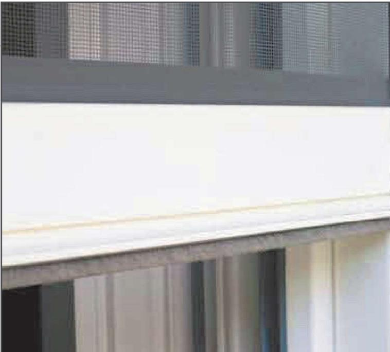
I suoi profili si armonizzano perfettamente al serramento rendendo la struttura della zanzariera invisibile e permettendoci di godere appieno dell'intero foro finestra, senza alcun intralcio. Inoltre in qualsiasi momento, possiamo sganciare le guide dai supporti posteriori in modo da agevolare le operazioni di pulizia.
