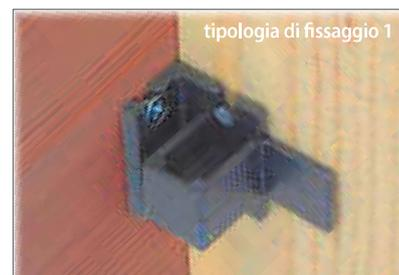
Appositamente predisposti, i compensatori consentono di fissare la guida e il profilo a "U" sul fondo del contro telaio per le installazioni in "cantiere" (tipologia 1) oppure di fissare la guida al serramento (tipologia 2) prima di recarsi in "cantiere", trasportando serramento e zanzariera già pre-montati.
